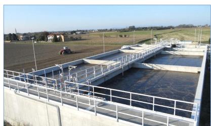
La fase di equalizzazione è necessaria per effettuare l'omogeneizzazione del refluo digestato separato e per equalizzare eventuali picchi di scarico giornalieri. La successiva fase di ossidazione/nitrificazione effettua prevalentemente l'ossidazione biologica della sostanza organica e dell'azoto ammoniacale presenti nel refluo.
